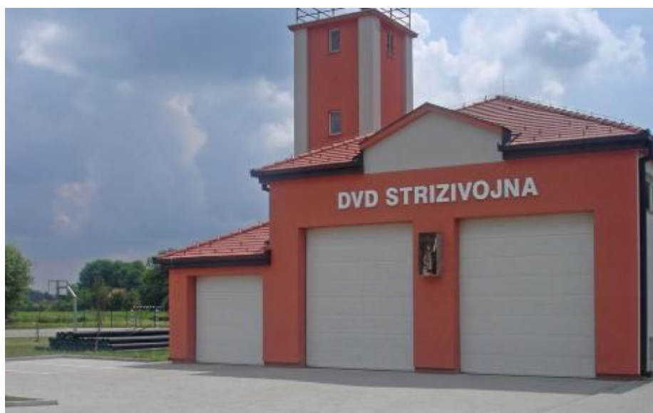
Slika 5. Zgrada DVD-a Strizivojna
